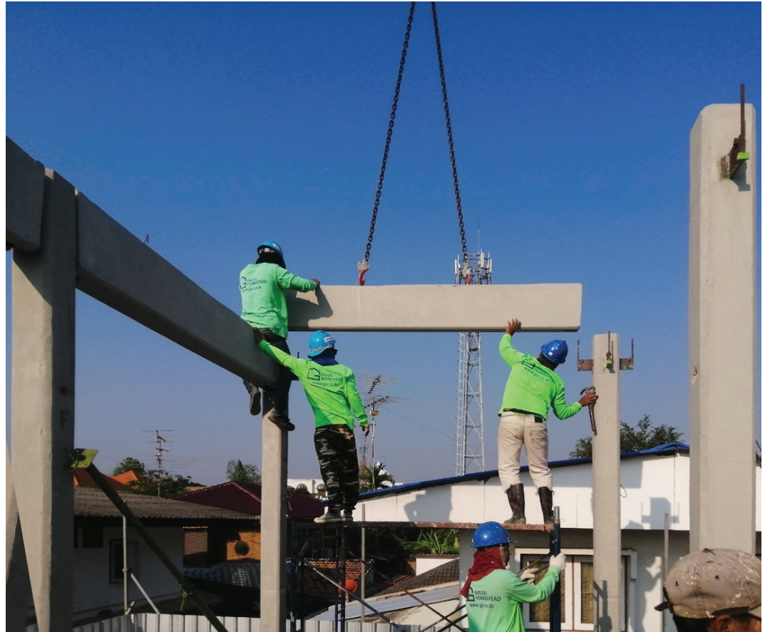
รูปที่ 1.5 ภาพการติดตั้งหน้างาน
