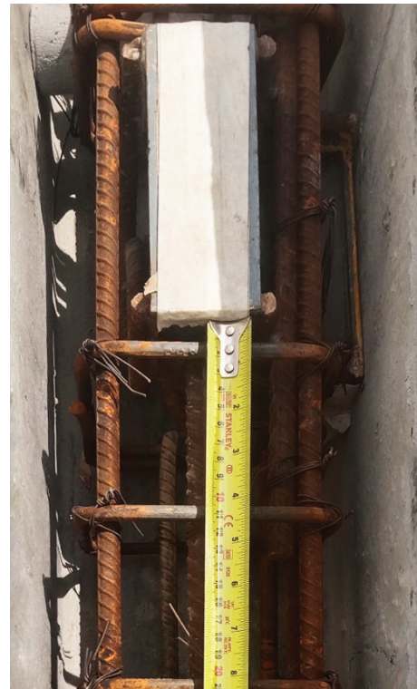
รูป 5.4 การตรวจสอบระยะจุดต่อและถ่ายรูปเก็บไว้
