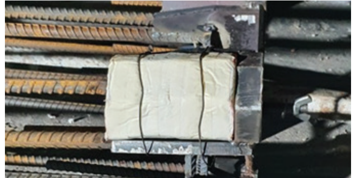
รูปที่ 4.6 การติดตั้งเบ้าโฟม
