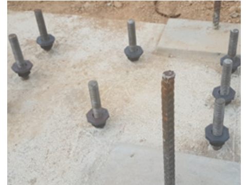
รูปที่ 4.13 การตั้งระดับ Anchor bolt
