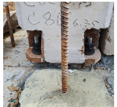
ภาพแสดงการติดตั้งจุดต่อ HFCS
